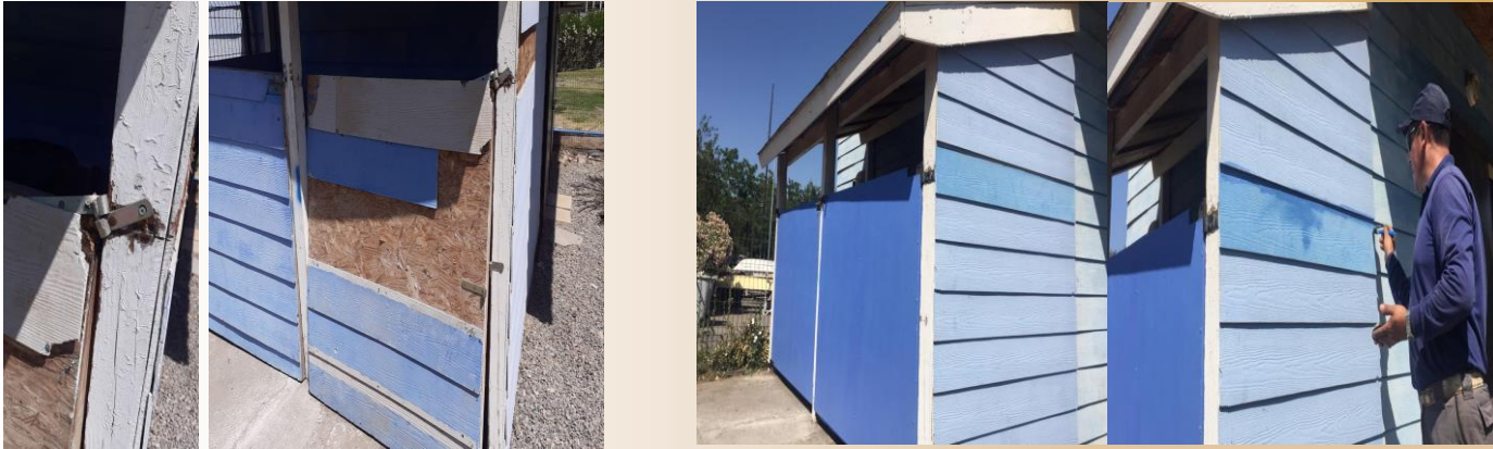
Reparación de puerta y pintura de caseta para basura en estacionamiento parque laguna
