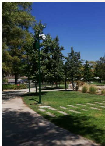
Instalación poste y 1 domo Parque laguna, sector juegos infantiles
