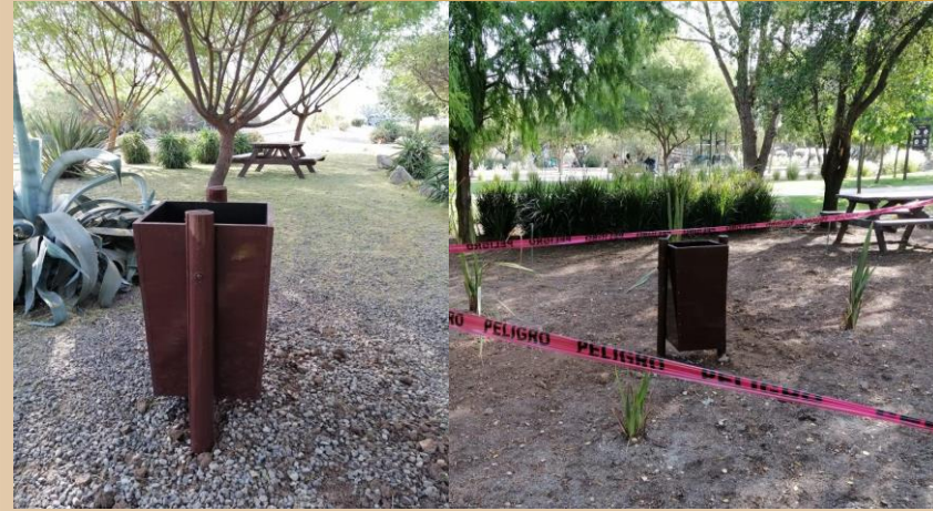
Construcción e instalación de basureros para sectores de picnic.
