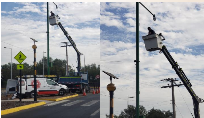
Instalación 1 domo Jose Rabat con Av. El Valle
