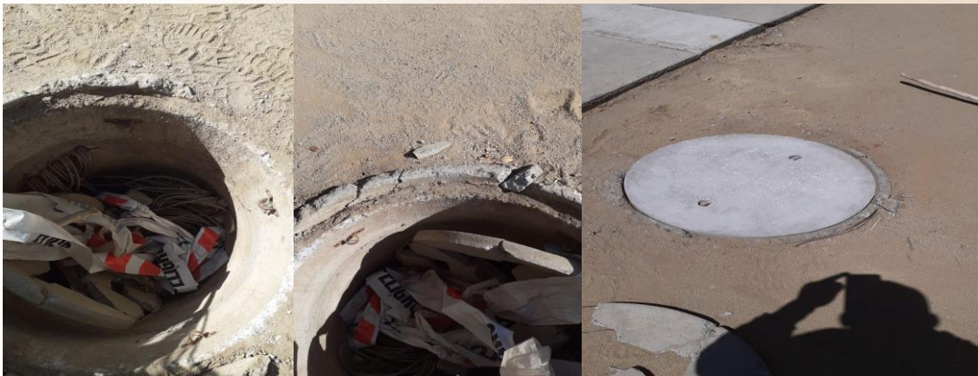
Se realiza reposición de tapas quebradas en parque laguna
