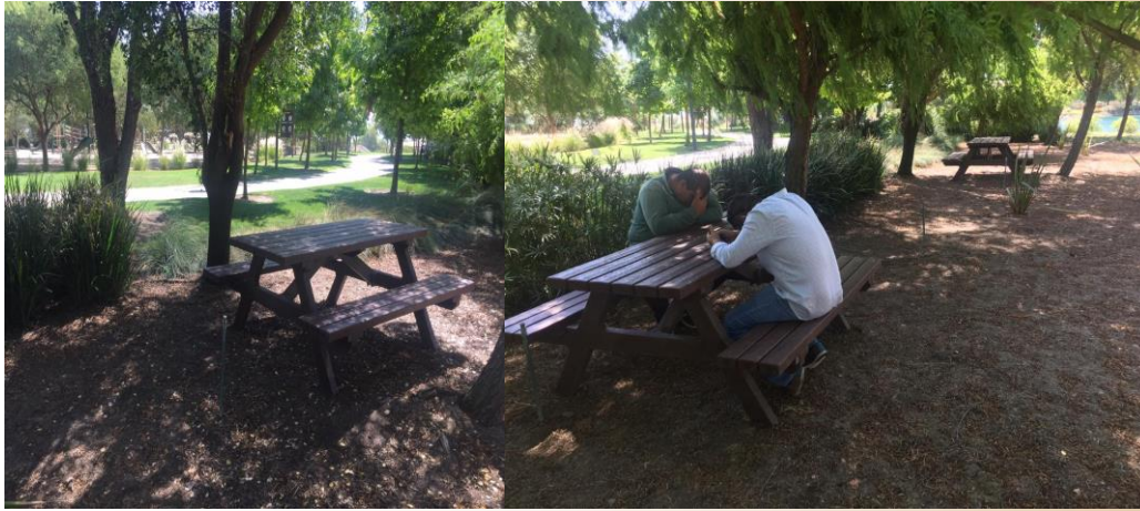
Instalación de 4 mesas de picnic en el parque (cercano a juegos infantiles)
