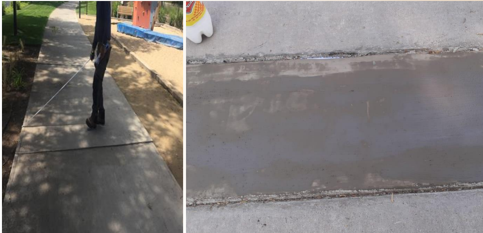
Reparación de sobresaltos en ciclovía en todo el parque laguna.
