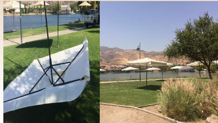
Instalación nuevas lonetas quitasoles
